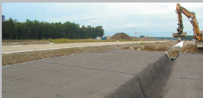
Proteção de águas subterrâneas com NaBento® em uma construção rodoviária.
