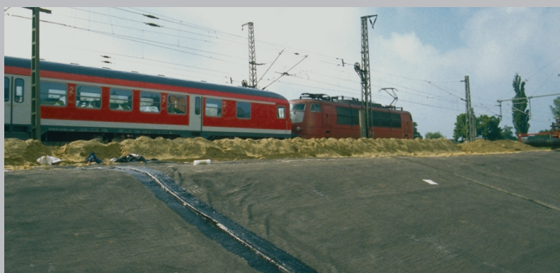
Revestimento ferroviário com NaBento®
