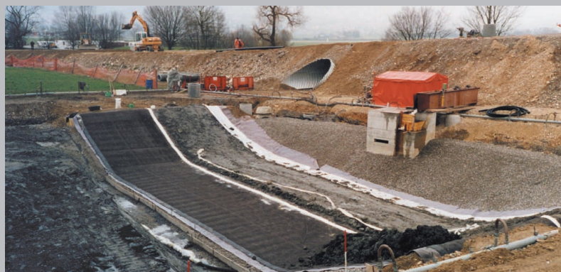
Lagoas de sedimentos – revestimento com NaBento®
