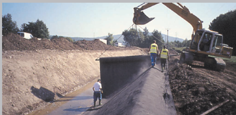
Revestimento de leito de rio com NaBento®
