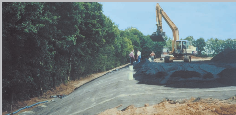
Cobertura de aterros com NaBento®
