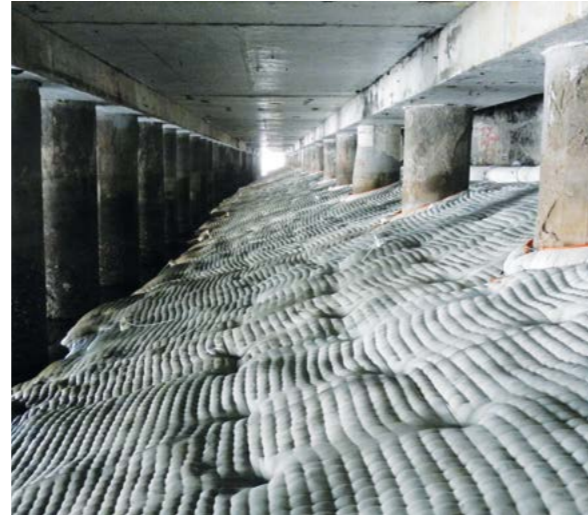
Protección de la base Guatemala | Protección de terraplén e inversión de la nueva terminal portuaria de Puerto Quetzal con Incomat Standard.
