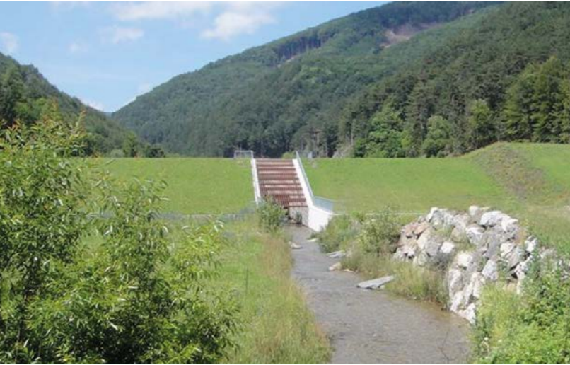
Sección de desbordamiento Austria | Protección contra la erosión de una sección de desbordamiento con Incomat Crib.
