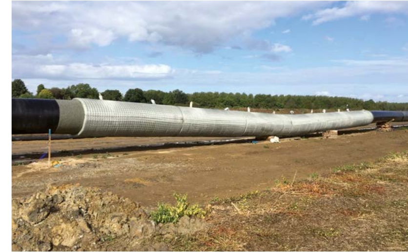
Protección y control de la flotabilidad Francia | Lastre y protección mecánica de una tubería con Incomat Pipeline Cover.
