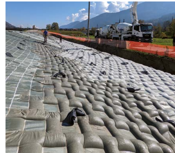
Protección contra la erosión Austria | Protección contra la erosión de una estructura con Incomat Crib.
