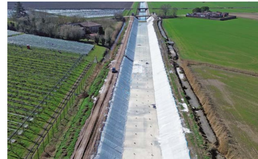
Revestimiento de conductos Italia | Sellado de un canal de riego con Incomat Standard.
