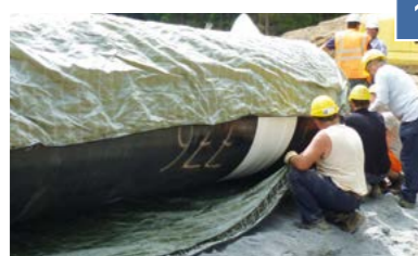
Fijación a la sección de tubería
