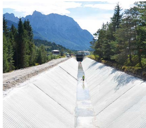
Renovación del alcantarillado Alemania | Revestimiento del canal de desbordamiento del Isar con colchón geosintético para hormigón tipo Incomat Standard.
