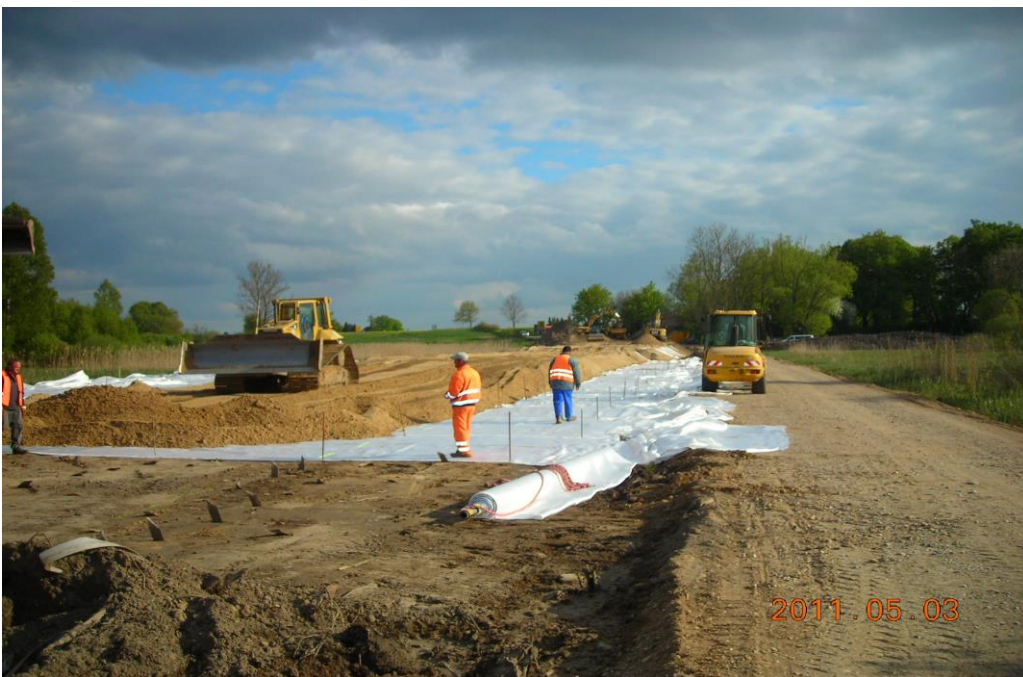
Abb. 2: L 261 bei Loitz mit Basisbewehrung und vorab eingebrachten Vertikaldräns
