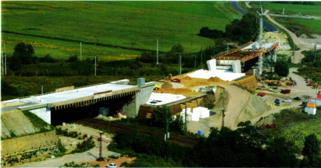
Abb. 3: Ortsumgehung Frankfurt/Oder, Dämme mit Basisbewehrung/ bewehrten 70° Böschungen und EPS im Kern (Quelle: Prospekt Rigips)
