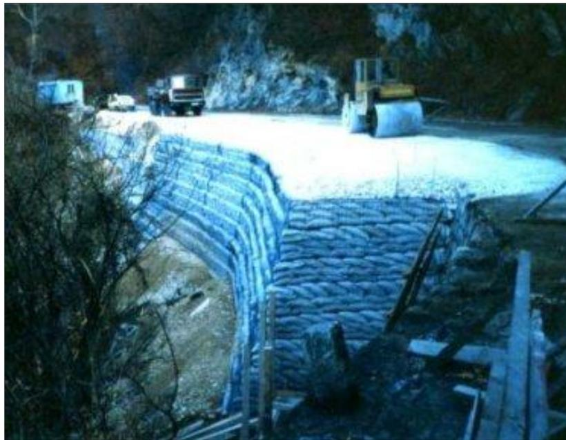
Figure 3: Projet "Jugovsko Hanche"- Fin de la construction du mur de soutènement avant la mise en œuvre du parement minéral Murallex
