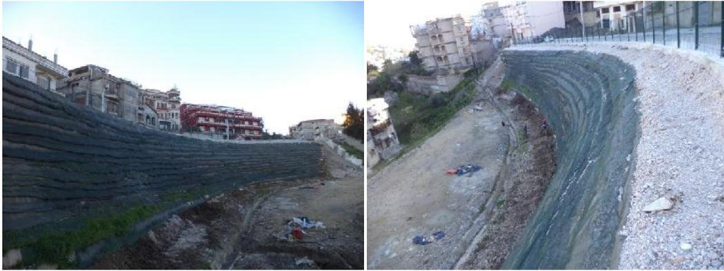
Figure 9 : Vue sur le massif de soutènement renforcé par des géosynthétiques
