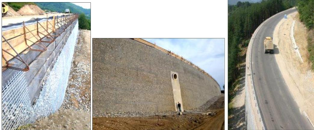
Figure 4. Projet « Route III-868 » - Mur de soutènement renforcé par des géogrilles de grande hauteur sans risberme à parement minéral Murallex®
