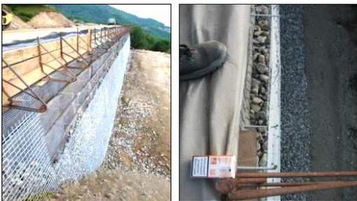
Figure 4. A gauche: phases de la construction (coffrage, géogrilles, barres d'ancrage, parement). A droite : vue de dessus du parement rempli de pierre
