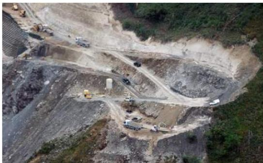
Figure 7 : voies de chantier
