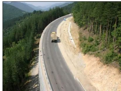
Figure 5. Vue de dessus d'un mur de soutènement renforcé par des géogrilles achevé
