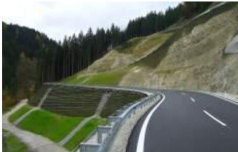
Figure 10 : vue partielle de talus en terre armée dans la zone des virages en épingle en vue de l'autorisation du trafic, été 2008
