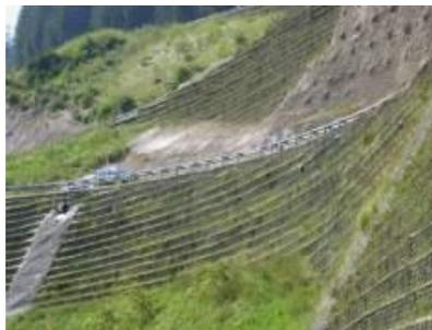
Figure 11 : vue partielle de talus en terre armée dans la zone des virages en épingle, été 2011
