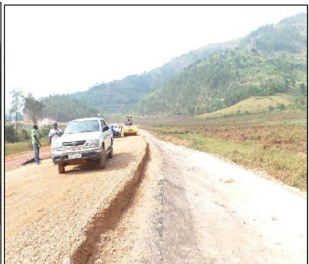
Figure 10 : Ancrage du géogrille
