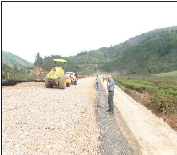
Figure 9 : Matériaux drainant sur le géogrille
