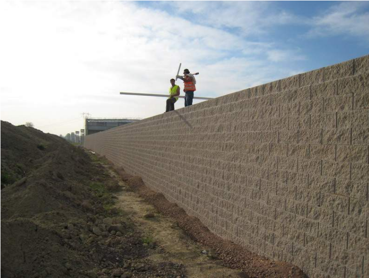
Fig. 9: vista del muro segmental durante la ejecución.
