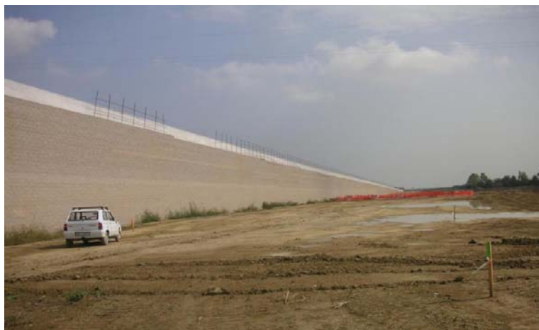
Fig. 11: vista del muro segmental en la fase final
