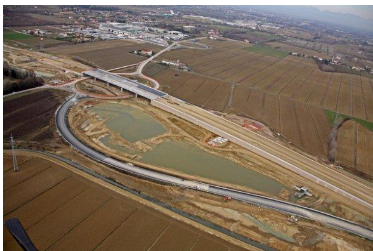
Fig. 12: vista aerea de la primera rampa
