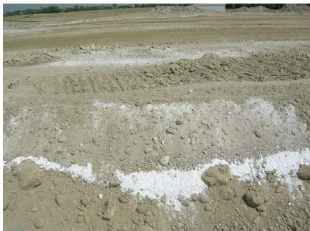
Fig. 4. Vista del suelo estabilizado con cal
