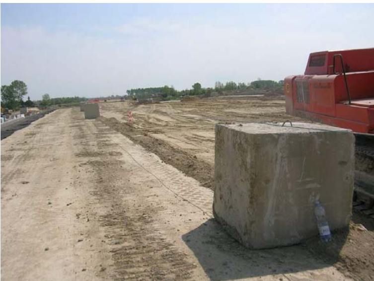
Fig. 10: Bloques de hormigón y cable de seguridad para ligar los obreros
