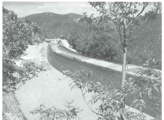
Fig. 12 - Vista da retro durante la fase di costruzione
