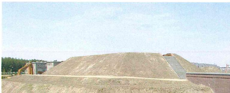
konnten die Setzungen reduziert und der Setzungsverlauf sowie der Porenwasserdruckabbau beschleunigt werden.
