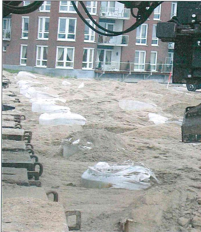
Abb. 7: Herstellung der GKS (GEC) im Bereich der Bastion-Ost
