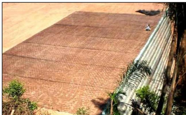
Figuras 5 e 6. Detalhe da rocha alterada na fundação e muro durante a fase construtiva.
