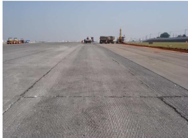
Figura 6 – (a) Processo de fresagem do pavimento e (b) Superfície do pavimento fresada
