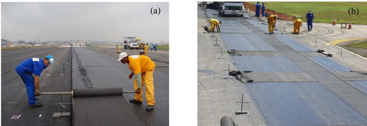
Figura 10 – Instalação da geogrelha de forma manual nas juntas do pavimento rígido
