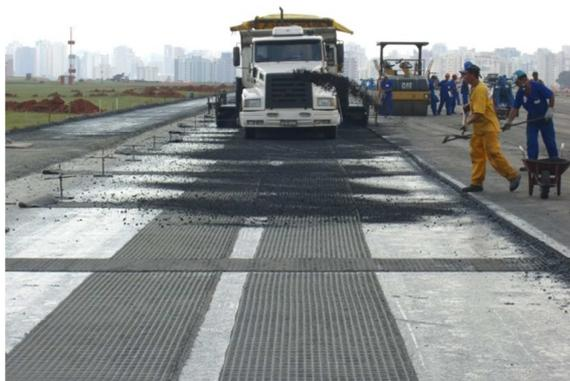
Figura 12 – “Salgamento” da geogrelha para a movimentação dos equipamentos.
