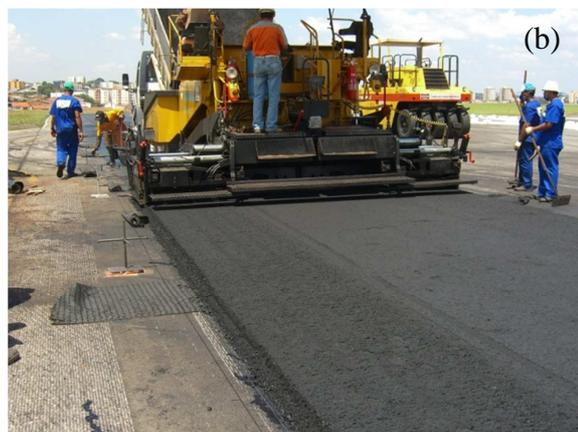
Figura 13 – Execução da camada asfáltica sobre a geogrelha.
