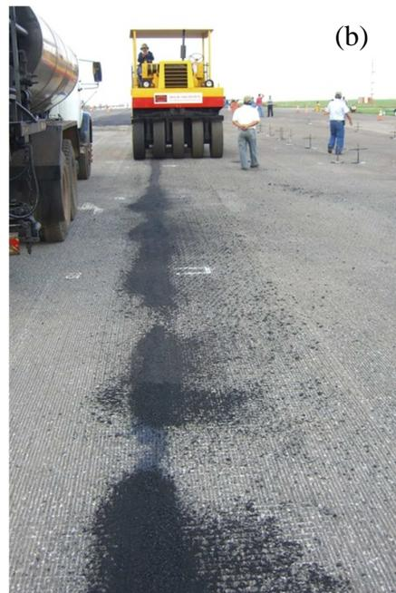
Figura 7 – (a) Massa fina para selagem da junta e (b) compactação da massa betuminosa na junta
