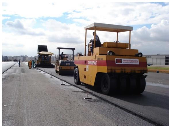
Figura 14 – Compactação da camada asfáltica.
