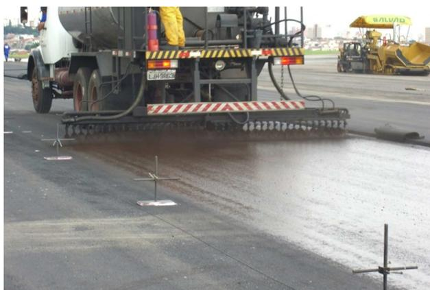
Figura 8 – Imprimação da superfície do pavimento
