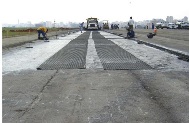
Figura 11 – Instalação da geogrelha sobre as trincas/juntas.
