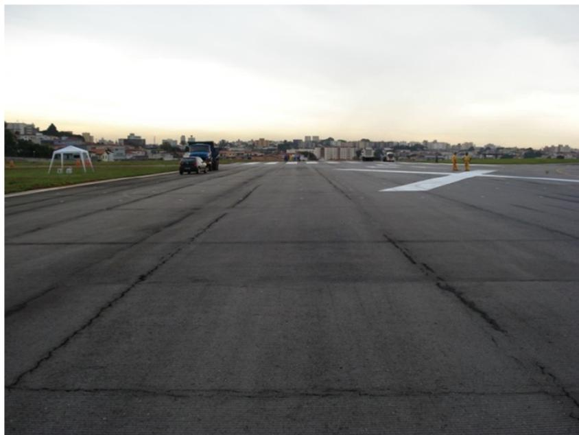
Figura 5 – Juntas das placas de CCP refletidas na camada asfáltica
