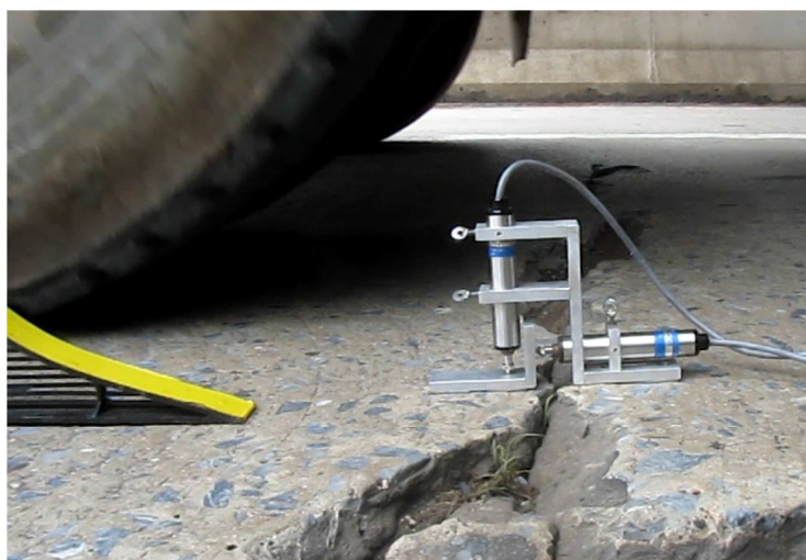
Figura 9 – Junta transversal da placa na Estaca 160.
