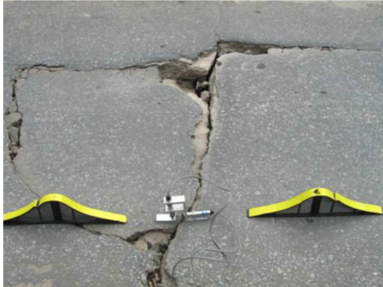
Figura 4 – Condição da placa na estaca 163.
