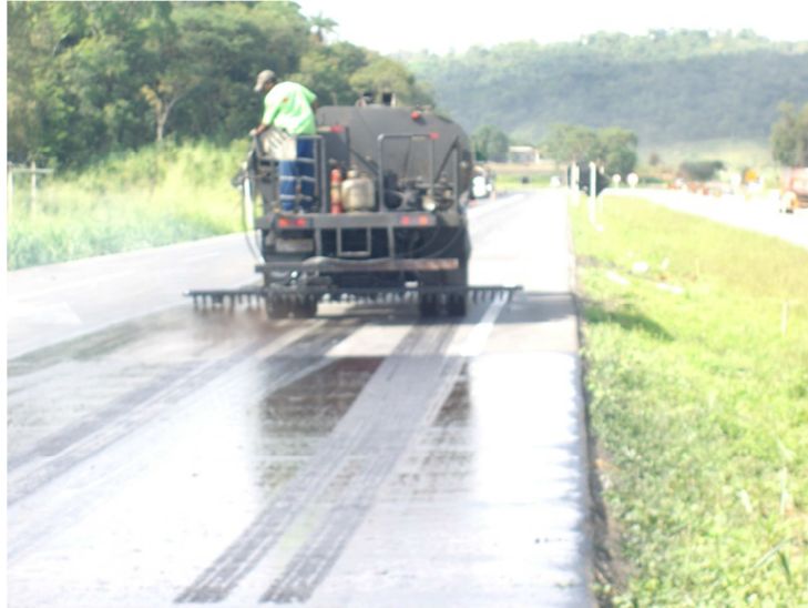
Figura 15 – Imprimação da superfície do pavimento
