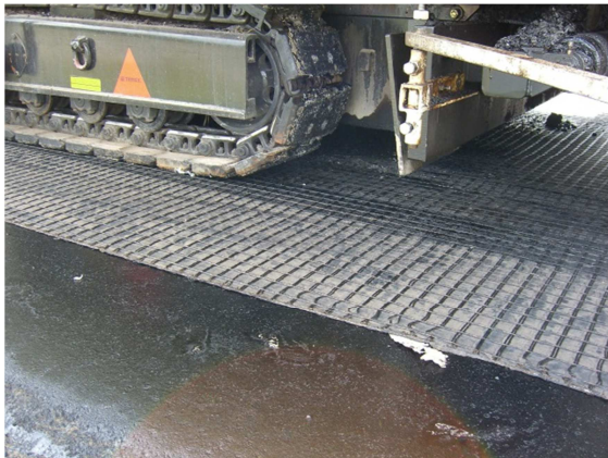
Figura 19 – Acabadora movimentando-se sobre o Hatelit C 40/17
