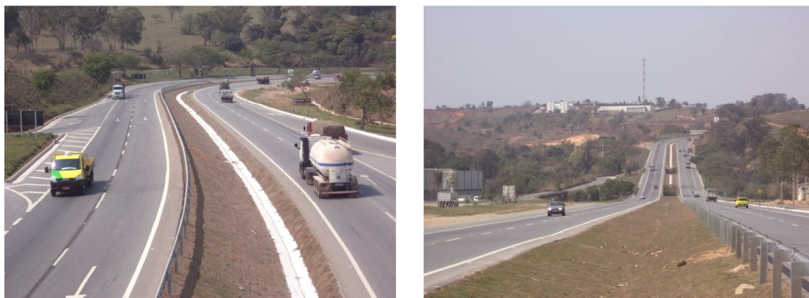
Figura 22 – Vista da rodovia MG-424 após restauração (Set./2014).
