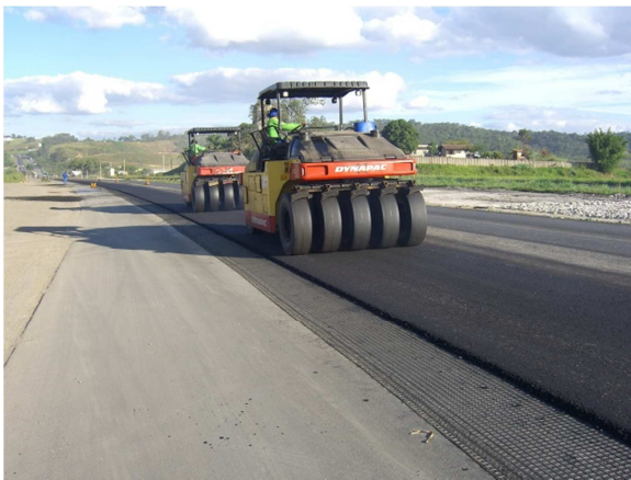
Figura 21 – Compactação da camada asfáltica.
