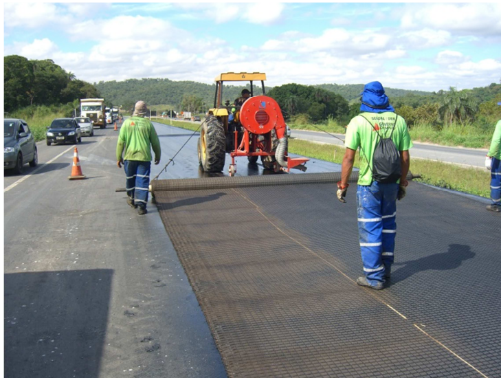
Figura 16 – Instalação do Hatelit C 40/17.
