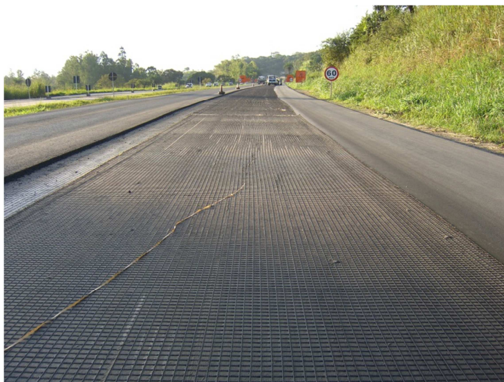
Figura 17 – Vista do Hatelit C 40/17 instalado.
