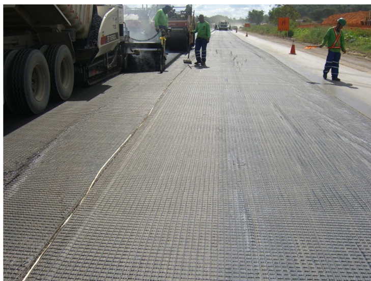
Figura 18 – Vista do Hatelit C 40/17 instalado e a execução da camada asfáltica (CBUQ).
