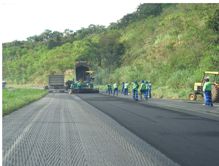
Figura 13 – Execução da camada de regularização na rodovia MG-424.
