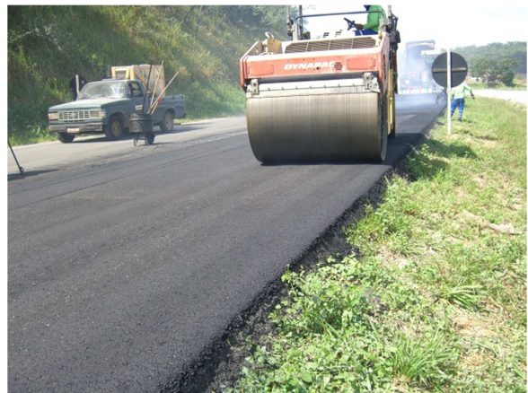
Figura 21 – Compactação da camada asfáltica.
