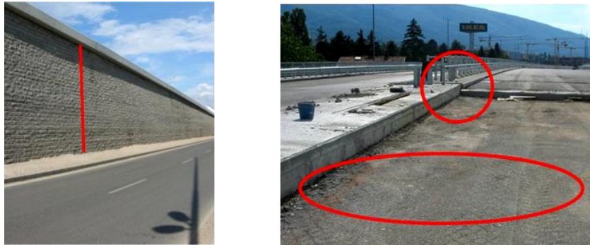
Figura 5. Inclinación perfecta (Izq.), ausencia de asentamientos diferenciales en el contacto puente-aproximación (Der.)
