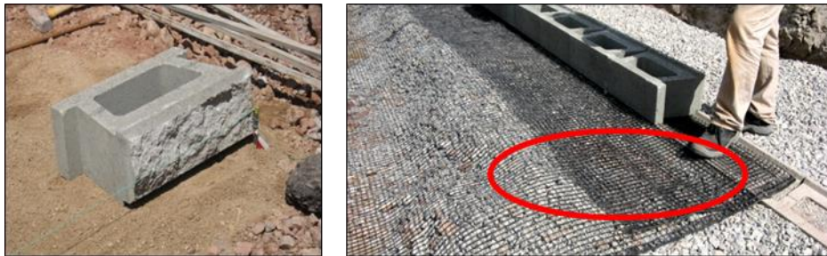
Figura 2. Izq: Bloque Segmental utilizado; Der.: detalle de la doble capa de geomalla para la conexión en la interfase bloque-geomalla-bloque
