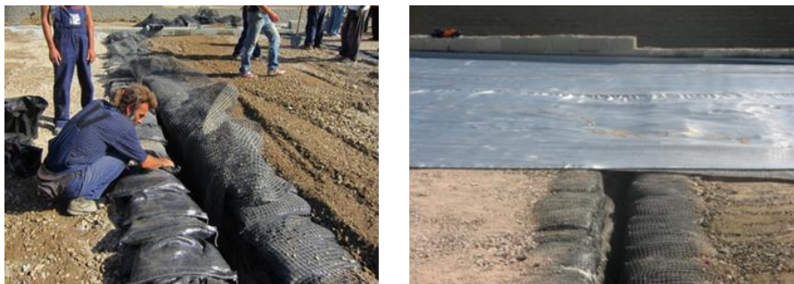
Figura 4. Conformación de la "Capa Blanda" en la parte superior de la separación en las alcantarillas y puenteo mediante geotextil tejido de elevado módulo.
